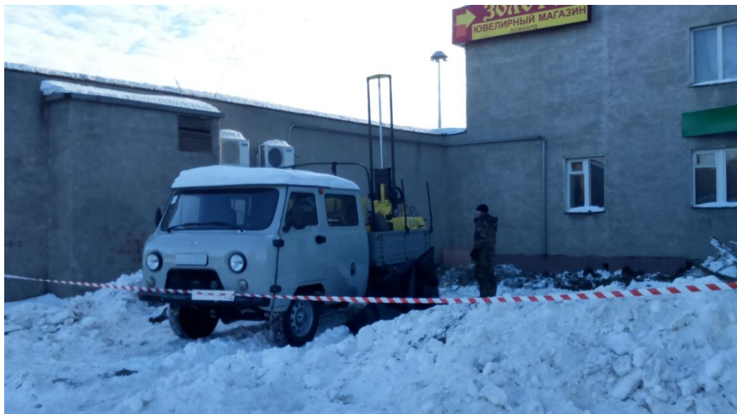
Рис.1. Бурение установкой на а/м УАЗ в центре города
